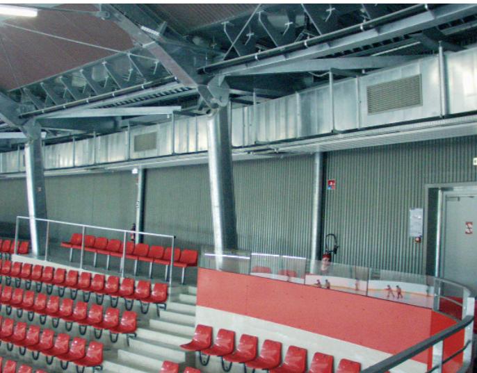
L'air est repris juste au-dessus des derniers gradins pour la zone spectateurs et sous la toiture de l'autre côté de la patinoire, à l'opposé du soufflage. Des sondes contrôlent que l'ambiance est maintenue à une humidité spécifique de 6 g/kg d'air en hiver, et 8 g/kg d'air en été.
