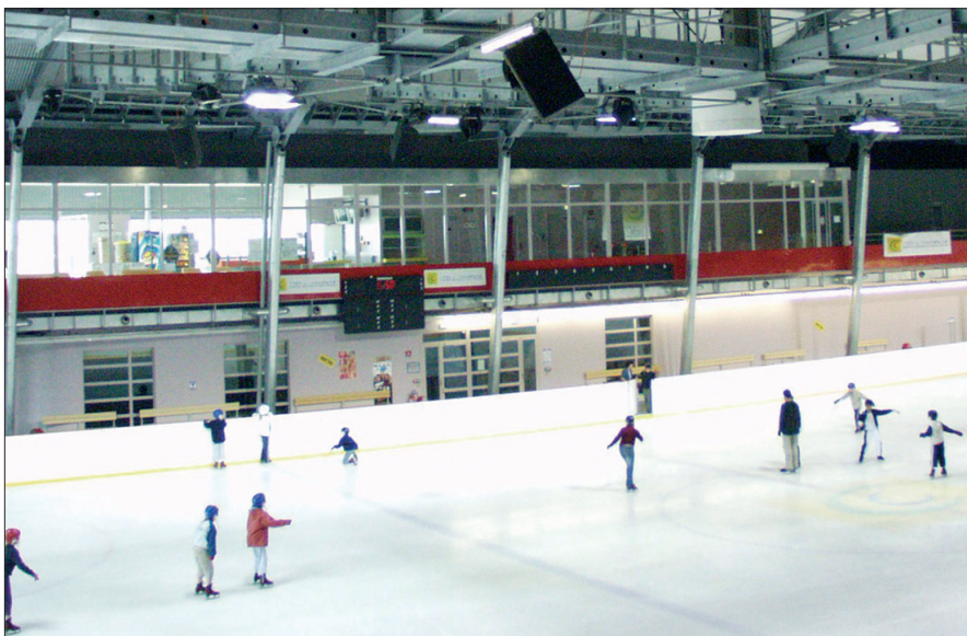
Une déshumidification de l'air de la patinoire est nécessaire pour limiter les apports de vapeur d'eau, liés à la présence des spectateurs et des patineurs, ainsi qu'à l'introduction d'air hygiénique, caractérisé par une humidité spécifique élevée, notamment en été.
