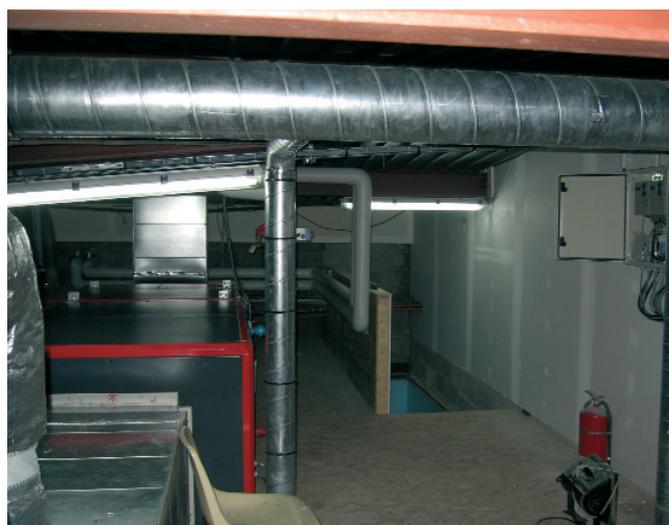
**Une centrale de traitement d'air simple flux (42 kW et 5200 m<sup>3</sup>/h), installée dans l'ancien local déshumidificateur, assure le chauffage du hall bassin.**
