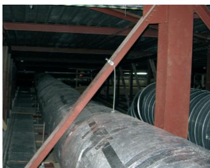
**Des cheminements ont été créés dans le plénum pour faciliter le travail des opérateurs de maintenance. Le conduit de ventilation fait office de garde-corps.**
