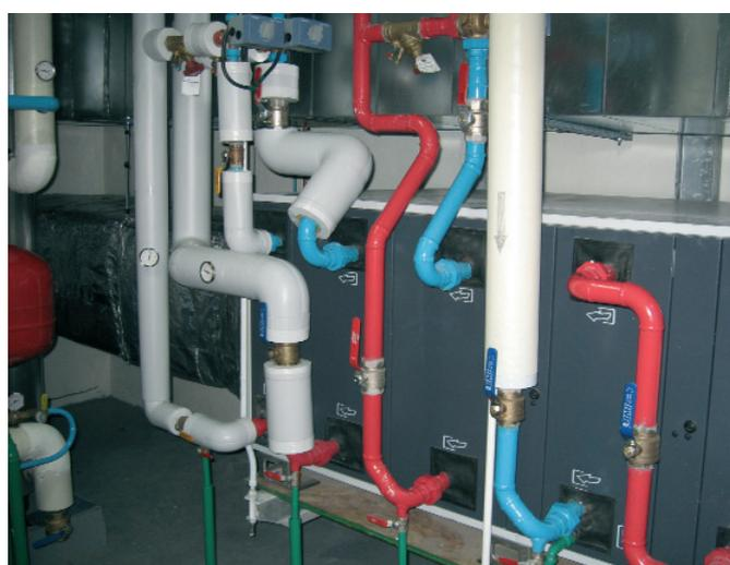
En absence de brouillard, la partie thermodynamique est à l'arrêt. La commutation entre régimes "brouillard" et "non brouillard" est manuelle : elle est réalisée par le responsable de la maintenance de la piscine au moyen d'un commutateur en façade de l'armoire électrique. Quand la déshumidification thermodynamique est enclenchée, le renouvellement d'air de la centrale de traitement d'air neuf est mis au débit minimal (2000 m<sup>3</sup>/h).
