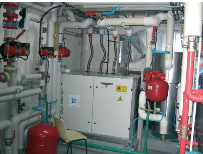
**La centrale simple flux est associée à une unité thermodynamique eau/eau CIAT qui assure une déshumidification thermodynamique de la piscine en période de brouillard.**
