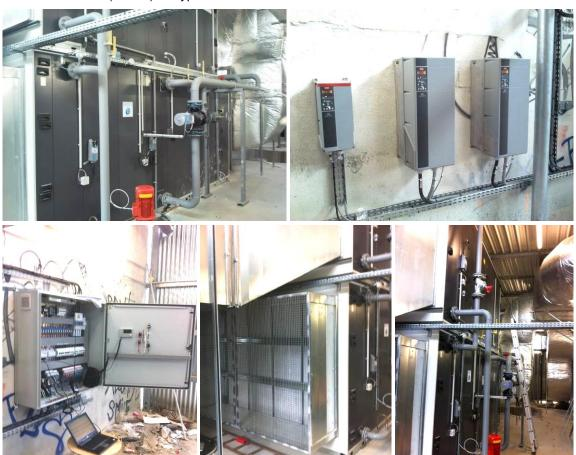
L'automate ECOTRONIC ® (exclusivité ECOENERGIE) contenu dans l'armoire électrique de commande et de régulation du système permet toute l'année de réguler la modulation d'air neuf, le chauffage de l'air soufflé, le débit d'eau dans le récupérateur enthalpique équilibré (REE) et de réaliser des réductions de débit d'air la nuit afin de réaliser en plus des économies d'énergie électrique liées au fonctionnement des groupes moto ventilateurs en période d'inoccupation.
