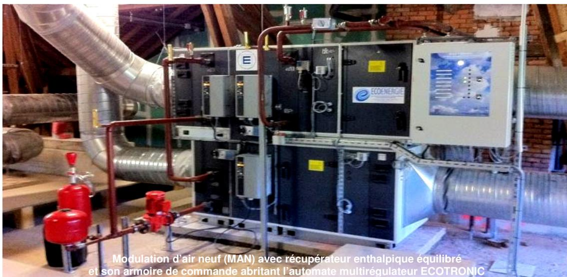
Système ECOENERGIE dédié au hall bassin n°1 : Système de traitement d'air et de déshumidification par modulation d'air neuf (MAN) avec récupérateur d'énergie sur l'air extrait de type **ECOMODUL G+**.
