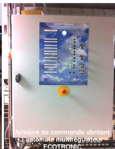
Système ECOENERGIE dédié au hall bassin n°2 : Système de traitement d'air et de déshumidification thermodynamique (THERMO) associé à une modulation d'air neuf (MAN) de type **ECOPMP+**.
