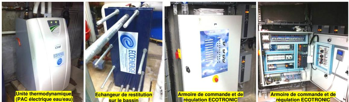
Le système « **ECODUG** » permet, en utilisant simultanément la puissance frigorifique et la puissance calorifique restituée de l'unité thermodynamique, par l'intermédiaire d'une CTA équipée d'une batterie froide (Du) d'une part, et de deux batteries de restitution et un échangeur en acier inoxydable raccordé au condensateur d'autre part :
