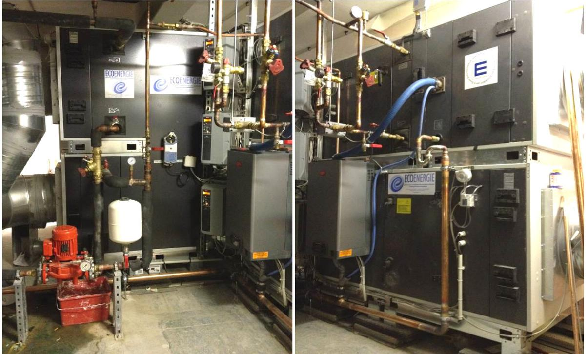
La régulation du système de traitement d'air est réalisée de façon automatique par un automate multirégulateur de type **ECOTRONIC**® contenu dans une armoire électrique de pilotage et de protection dédiée au système.
