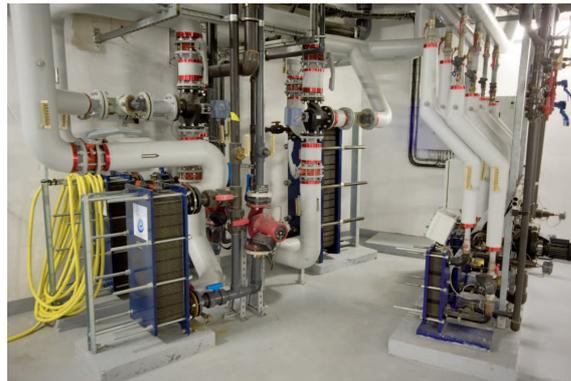
L'eau chaude en sortie du bouilleur de la Pac à absorption alimente les trois échangeurs de réchauffage de l'eau des bassins.
