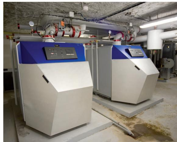
Deux chaudières gaz à condensation et à brûleur modulant Atlantic Guillot de 980 kW produisent la chaleur pour la mise en température des bassins et l'alimentation de la pompe à chaleur à cycle à absorption.
