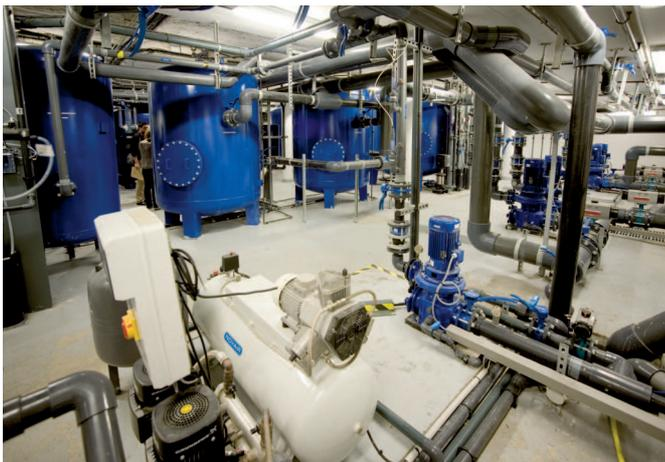
Le local technique dédié à l'alimentation des bassins de la piscine. Toutes les pompes sont gérées par une électronique de pilotage à vitesse variable.
