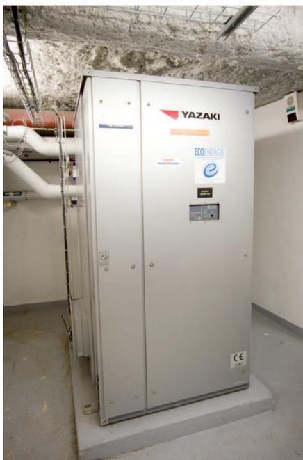
La pompe à chaleur Yazaki de 70 kW froid. Son bouilleur reçoit une eau à 88 °C et produit par échange thermique une eau glacée à 7 °C et une eau chaude de rejet de 35 °C. Ces deux flux sont exploités dans les centrales de traitement d'air de déshumidification et chauffage du hall des bassins.
