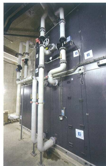
Cet EcomodulG+ 600 traite l'ambiance des bassins ludiques. Les calories de l'air humide repris sont exploitées pour réchauffer le volume du hall.
