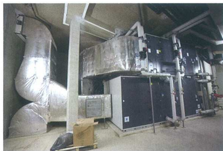
La CTA EcomodulG+ 50, mise au point par ÉcoÉnergie pour le traitement des bassins chaud/froid/fitness. Son taux de brassage est de 5,95 volumes/heure.
